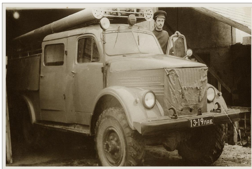
P/s Lone ugunsdzēsības tehnika – autocisterna un četri motorsūkņi
