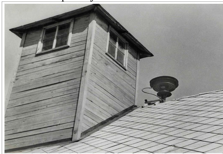
Latvijas PSR Jēkabpils rajona padomju saimniecības Lones BUK tornis un sirēna
