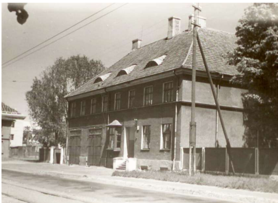
(Strukturvienības ēka Slokas ielā 66, Rīgā 20. gs. 60.tie gadi)
